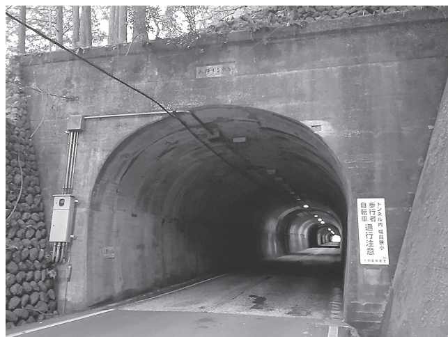
工事が完了した入野トンネル
