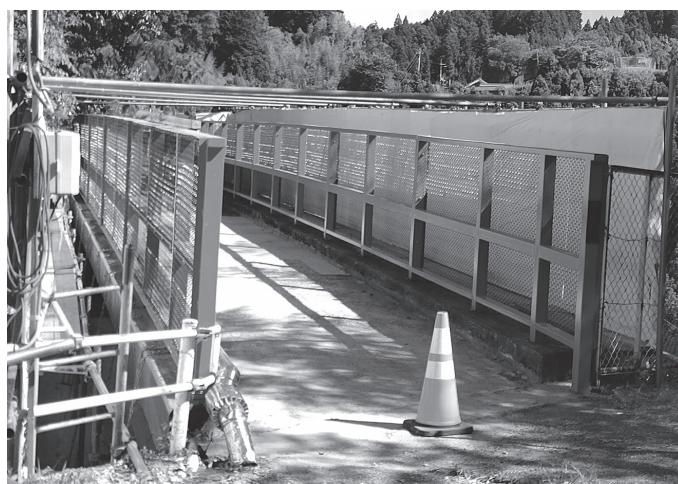
工事はほぼ最終段階に入っている
