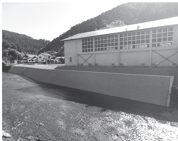
完成した護岸、出水期明けに整備は推進される
