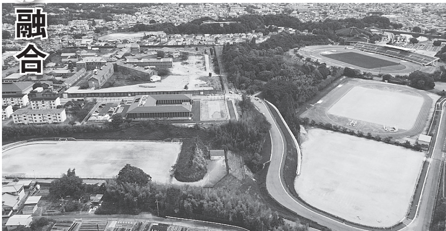
鴻ノ池運動公園エリア。左上が旧奈良監獄(奈良市提供)
