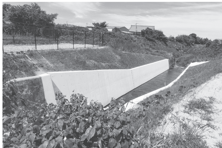
修復された護岸
