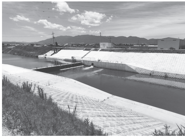
重井出井堰、上流に向け整備が推進されてゆく
