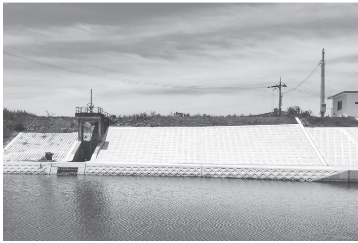
今回整備された箇所(左岸側)
