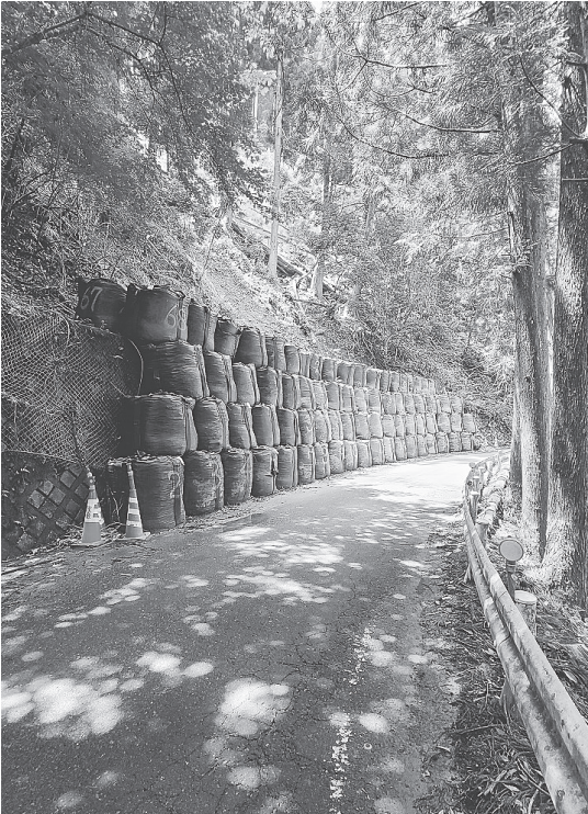
土嚢より上の部分に防護柵が設置される
