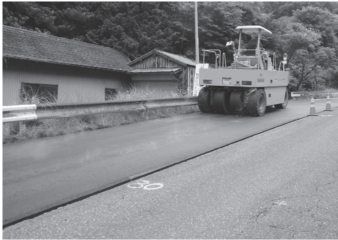
舗装は仕上げの段階（撮影 6月23日）
