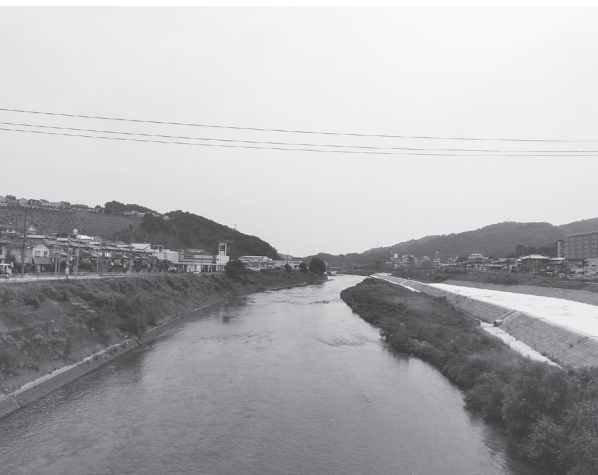
神前橋より撮影、手前の護岸は施工を終えている
