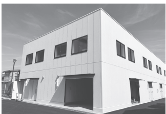
完成した倉庫棟
