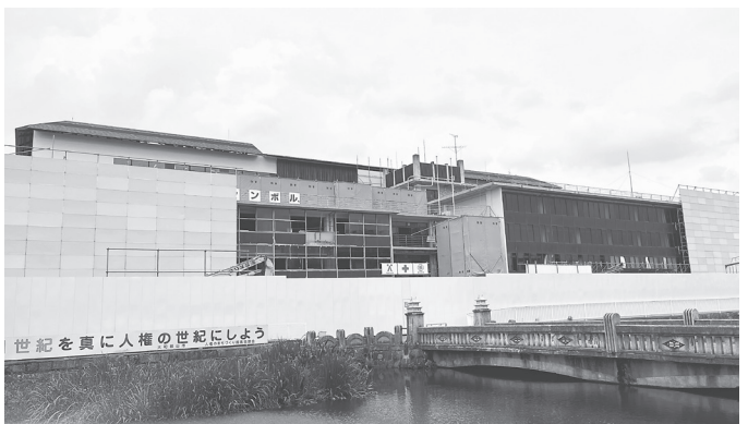
解体進む旧庁舎 後方上部に新庁舎棟が見える
