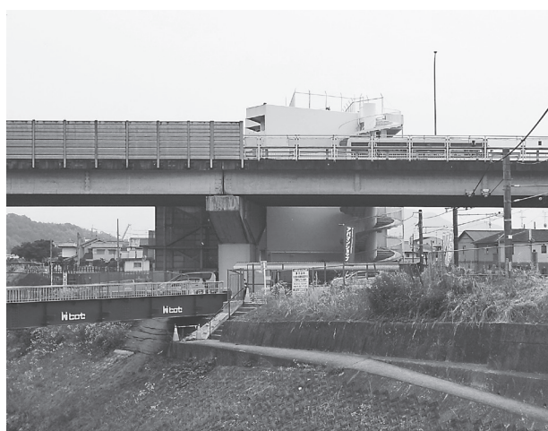
夜間に工事が進められている「王寺跨線橋」
