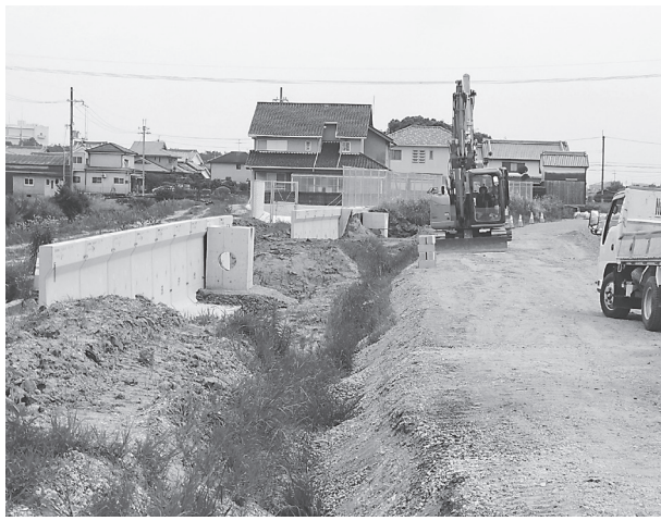
整備が進められている「長楽工区」
