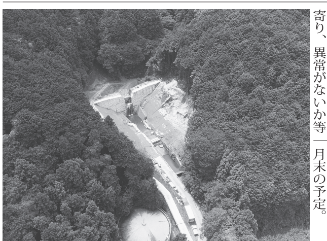
工事再開は9月下旬(遺跡は現場右側斜面)
