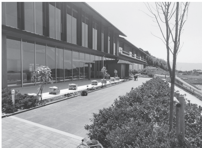
植樹作業が進んでいる
