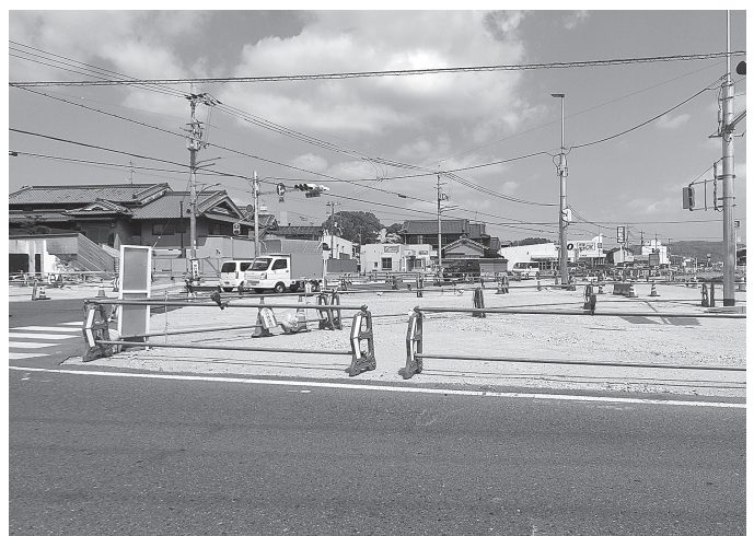
今年度、工事の発注が予定されている「王寺道路」の未供用部
