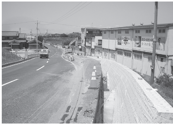
自転車道の安全性を高める工事が進む
