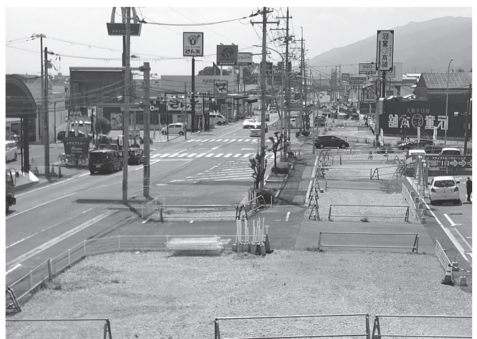
現在、電線共同溝工事が行われている「香芝王寺道路」
