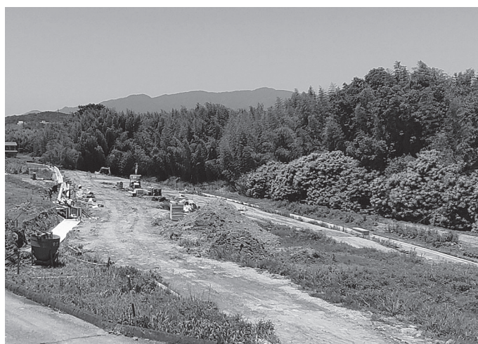
堤防上に道路を新設する
