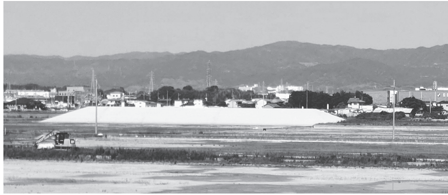
周囲堤の工事が進められている
