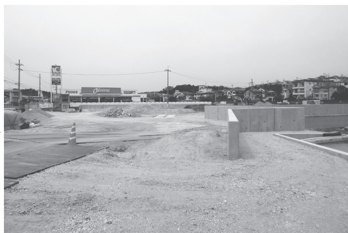
造成工事が進む建設地
