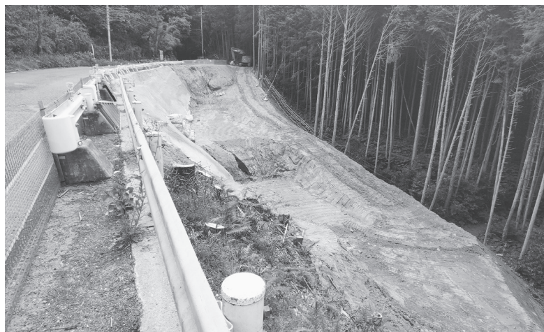
拡幅整備が急がれている「須川工区」
