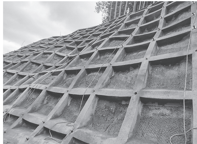
山体の補強終わり植生基材吹付工に移る
