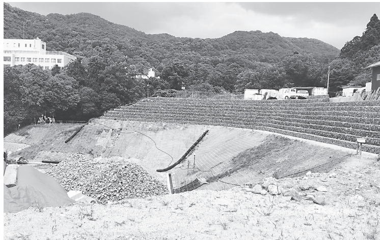
アンカー工は完了、護岸の工事に取りかかっている
