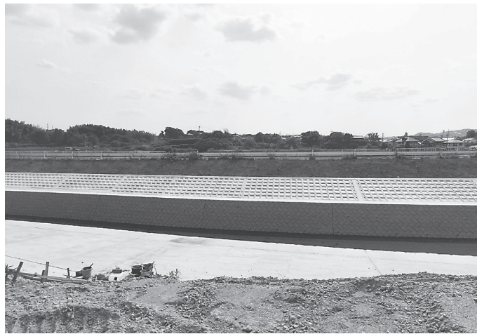
完成した護岸
