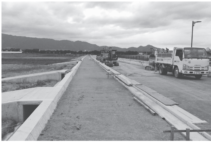
松村組の施工で工事が進んでいる
