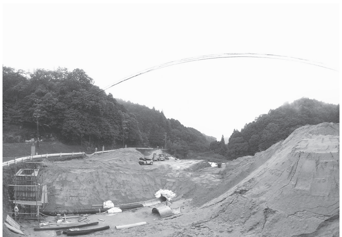
拡幅のための盛土工が行われている
