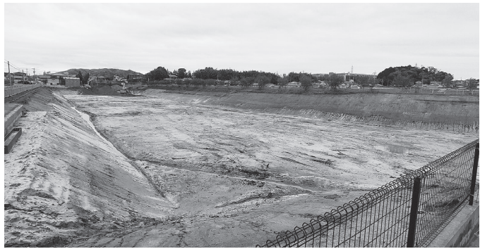
掘削作業は終盤にかかっている
