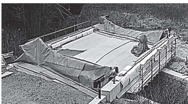
3年度内に完了した(仮称)3号橋上部工事
