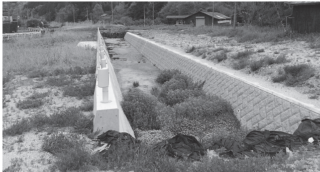
バイパス整備に合わせ河川も整備される
