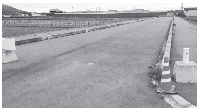
工区北側は新たな道路を整備
