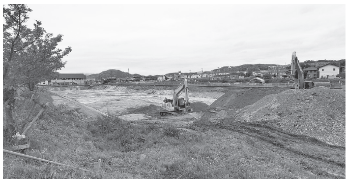
今年度は樋門の設置が予定されている(撮影:4月15日)
