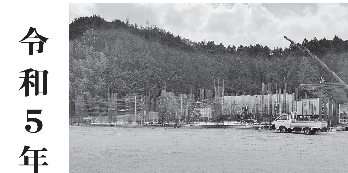
躯体の建築に取りかかっている火葬施設
