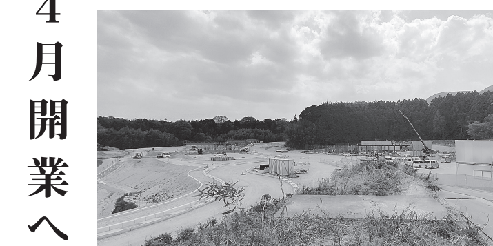
園地エリアの造成も進んでいる
