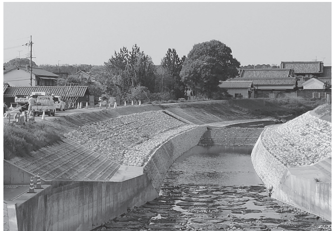
景観にも配慮され施工されている秋篠川
