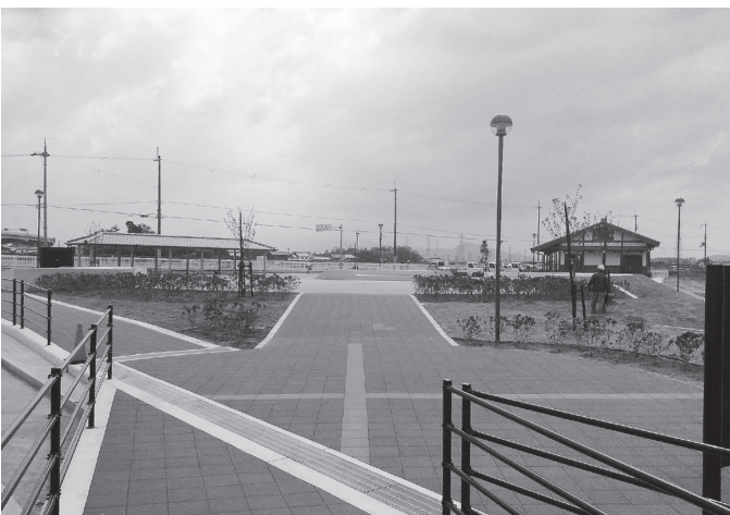
完成間近の休憩施設 (撮影:4月14日)
