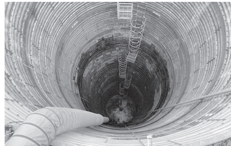
流入仮説立坑設置工事は3月に完了
