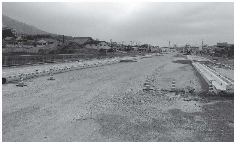
工が進むバイパス部分 (撮影:4月14日)
