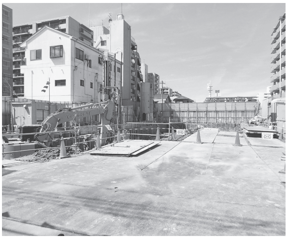
基礎工事が進む現場の様子 (4月1日撮影)
