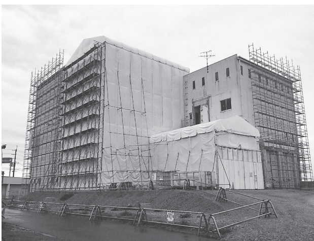
汚染物質飛散防止のためシートで覆われた環境美化センターの建屋
