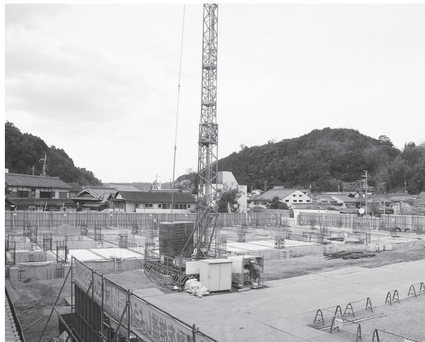
現場では支柱の立ち上げに取りかかっている
