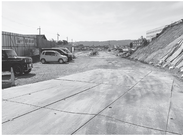
自動車整備工場の建設地
