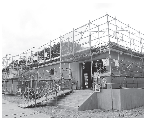
同時に施工されているプール棟
