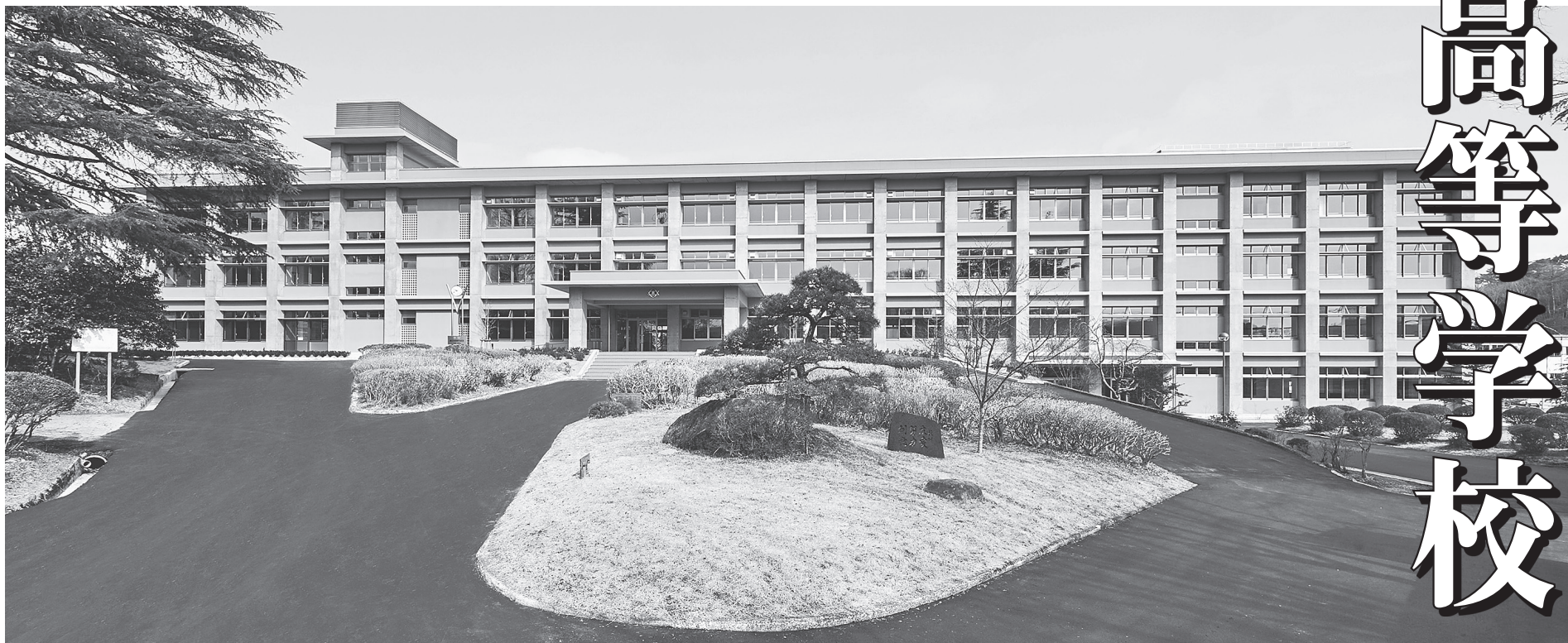
改修しリニューアルされた新校舎
