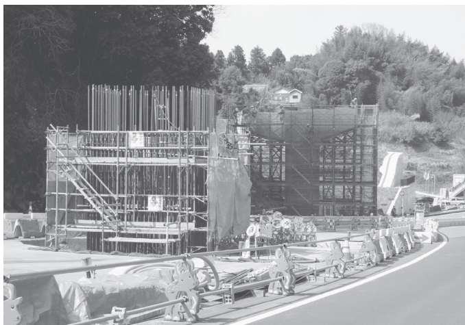
躯体が上がってきた橋脚〔P2〕(左)と完成に近い〔P1〕(右)
