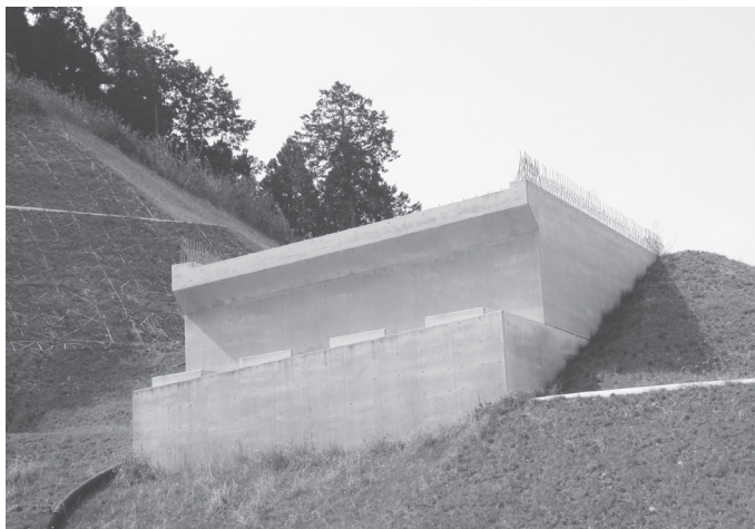
橋台〔A1〕は完成：撮影3月30日
