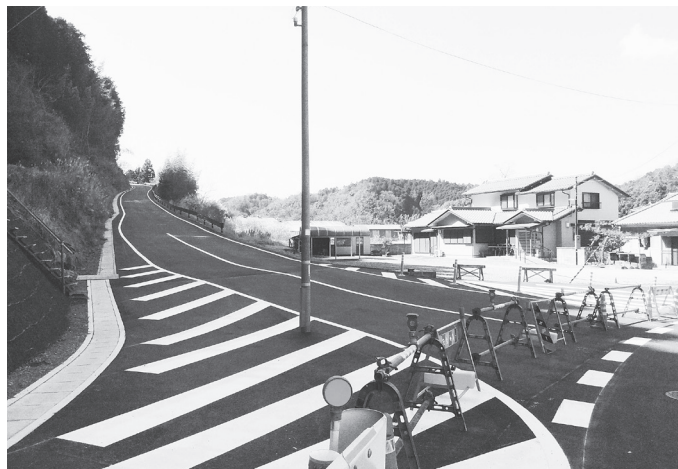
4年度内に供用開始する橋屋バイパス
