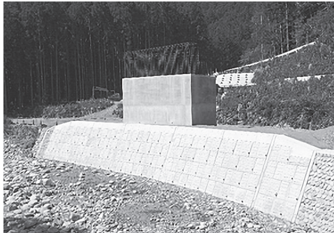
完成した深瀬1号橋橋梁下部
