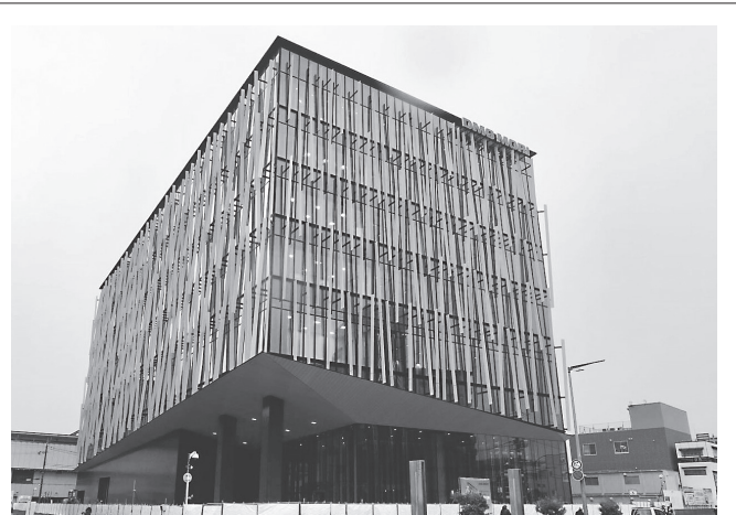
建設中の奈良商品開発センター(3月23日撮影)
