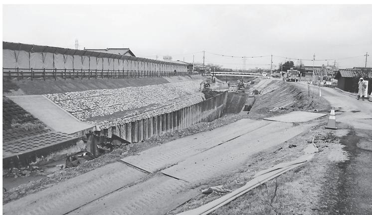
・工事延長L1140m、アンカー式空石積工A11267m、自然石固着金網張護岸工A11506m
