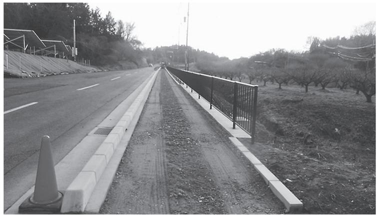
・工事延長L=152m、場所打擁壁工V=30m、縁石工L=94m、防護柵工L=109m
