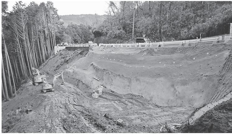
・工事延長L=90m、補強土壁工A=250m、軽量盛土工V=630m
