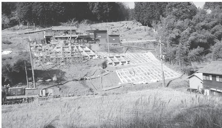
・工事延長L1155m、グラウンドアンカー工N1126本、吹付砕工L1134m、簡易吹付法砕工A1126
