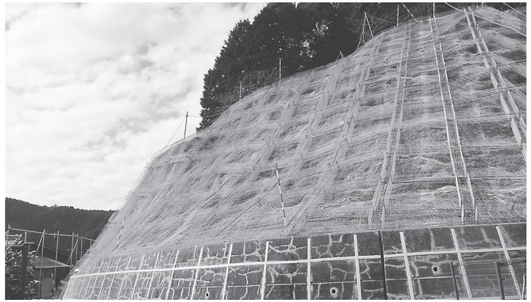
・工事延長L=82m、鉄筋挿入工N=388本、吹付法砕工L=1425m
