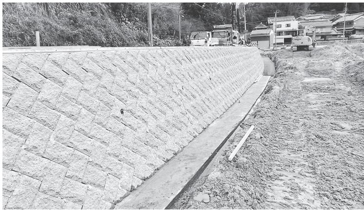
・工事延長L=248m、コンクリートブロック積工A=389m、側溝工L=222m
