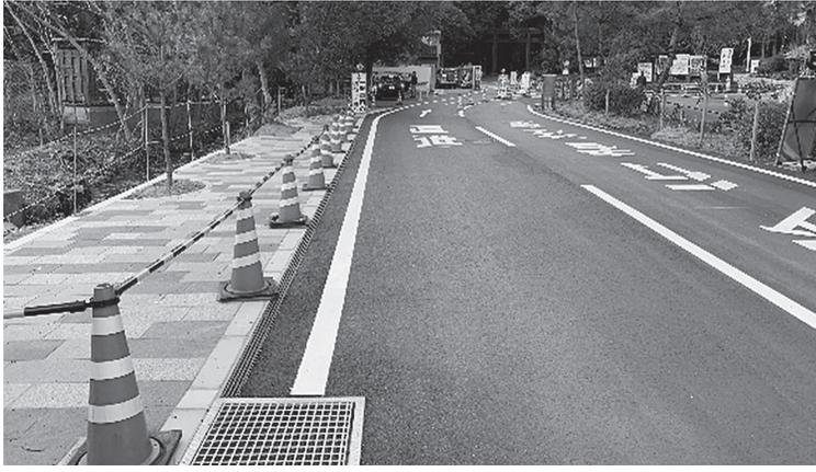
・工事延長L=154m、電線共同溝L=68m、歩道工A=104.1m、参道工A=55.2m
