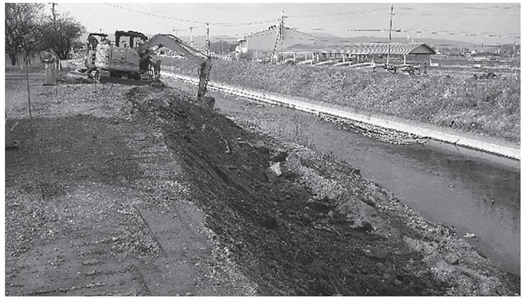
・工事延長L=34m、コンクリート護岸工L=34m、張ブロック工A=144m<sup>2</sup>
