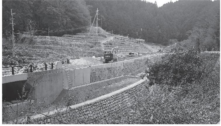
・工事延長L=173m、掘削工V=2200m<sup>3</sup>、補強土壁工L=217m、法覆護岸A=89m<sup>2</sup>
