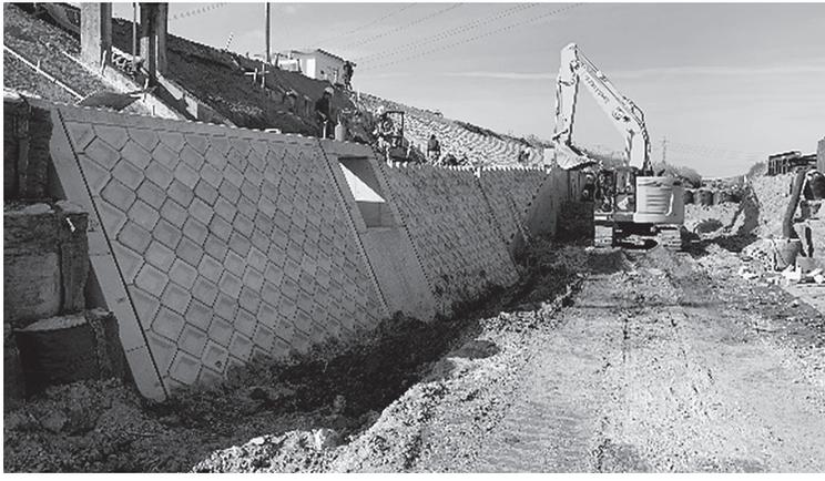
・工事延長L=26m、取付擁壁工L=9m、ブロック積擁壁工L=14m
