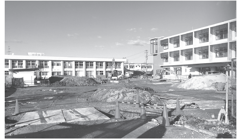
整備進む磯城野高校特別教室棟改築工事
