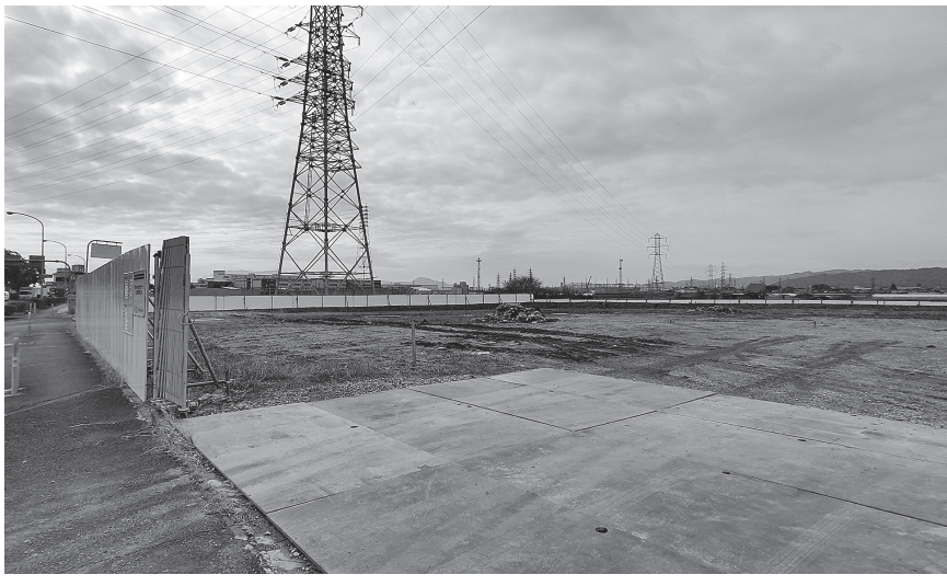
新工場の建設地（大和郡山市発志院町）
