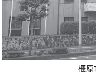
樫原市現本庁舎
