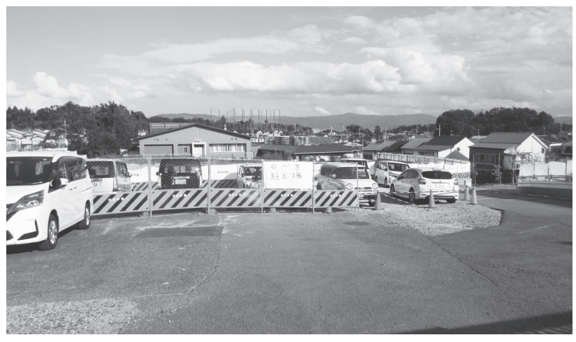
藤の木学園の現況（第1期建築で新施設居住棟が完成している）
