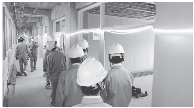
配線状況を点検する様子
