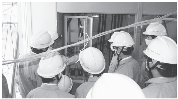
盤内の接続状況を学ぶ様子
