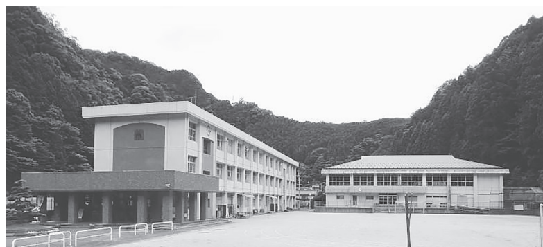
解体工事が行われる旧川上小学校
