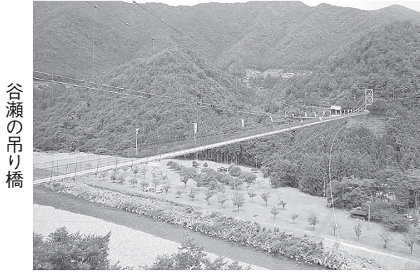
谷瀬の吊り橋
