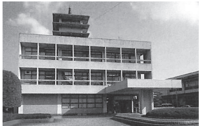
来年度に解体を予定している当麻庁舎
