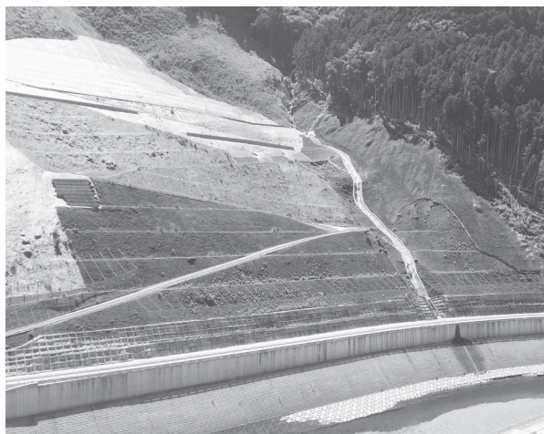
護岸工(上流側)
