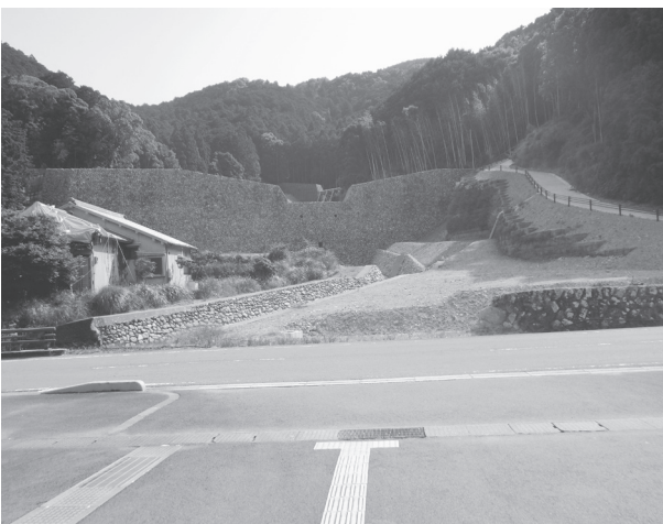
1号堰堤(鳴子川)
