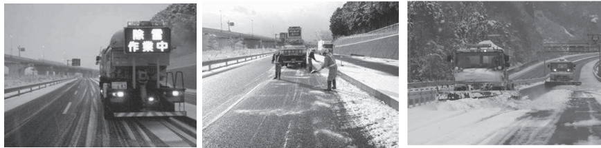
凍結防止剤散布状況
