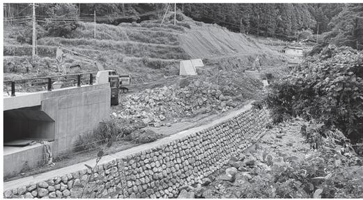
主要地方道桜井吉野線百市工区道路改良工事(補強土壁工事)
