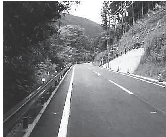
小川～鷺家工区 650 mが完成
