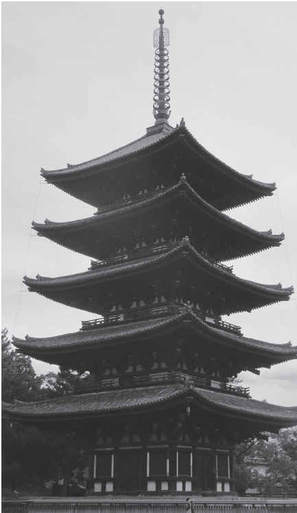
保存修理が予定されている興福寺五重塔
