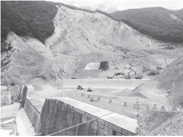
崩落斜面直下での3号砂防堰堤工事
