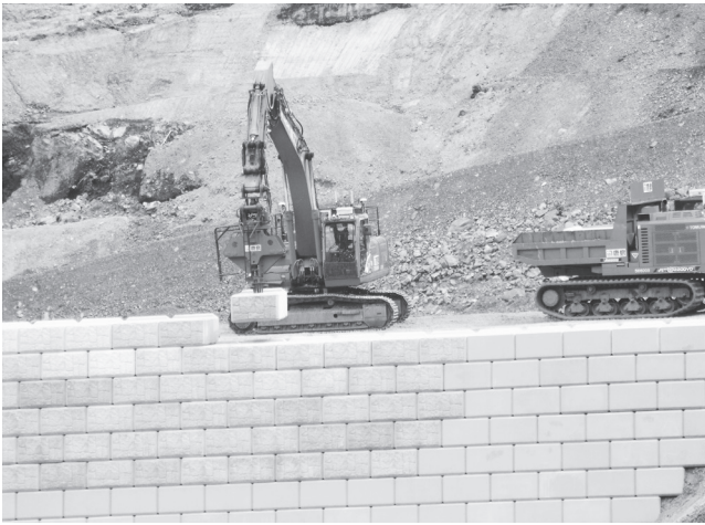
ブロック設置は自動化(左)、運搬は無人化(右)
