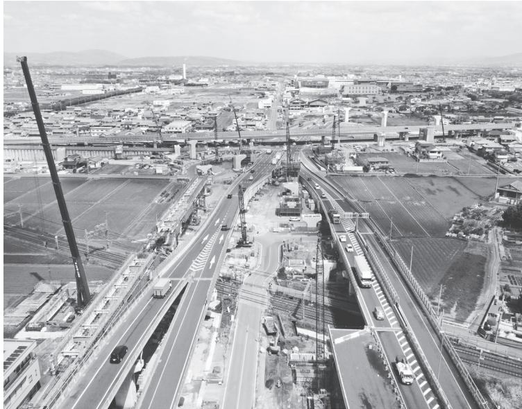
大和御所道路(新堂交差点から南側から北方を望む 橿原JCT橋梁上下部工事状況)
