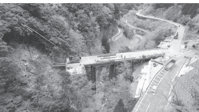
伯母峯峠道路(2号橋南側望むA1橋台土留工施工中・A2橋台完成)
