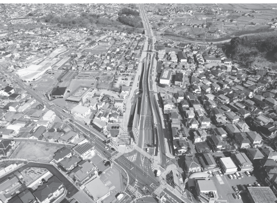
いかるがパークウェイ(三室交差点から東方を望む 開通後状況)
