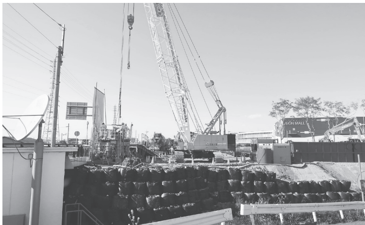
大和北道路(大和郡山市イオンモールから南側から北方を望む 橋梁下部工事等国道24号を東側に付替)
