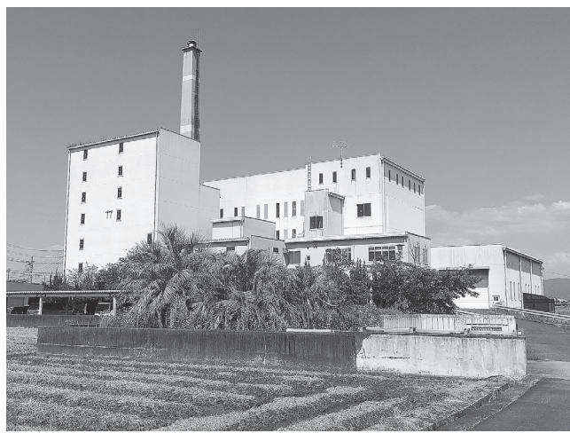
安堵町環境美化センター
