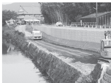
大和川擁壁工事
