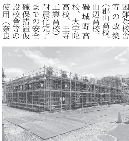
郡山高校特別教室棟改築工事
