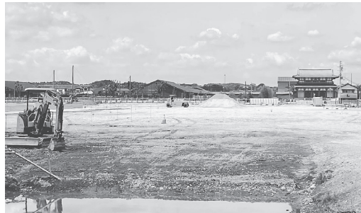
平城宮跡南側地区駐車場整備工事
