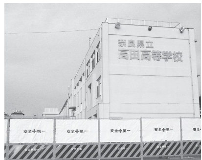
高田高校普通特別教室棟耐震・大規模改修工事
