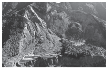
ドローンが撮影した崩壊斜面
