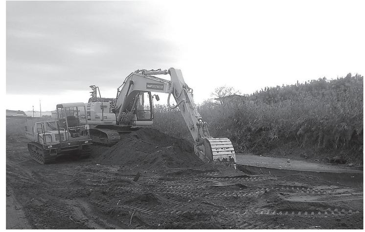
・工事延長L=575m、掘削工V=8500m<sup>3</sup>、掘削工(根混じり土)V=2500m<sup>3</sup>
