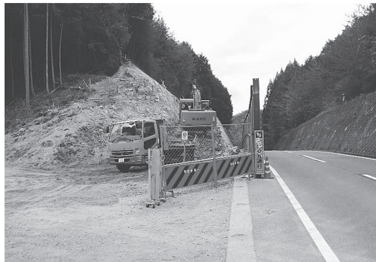
施工:株式会社 上田工業
