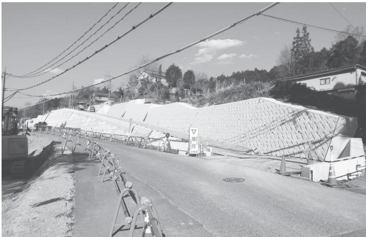
・工事延長L1183m、帯鋼補強土壁工
