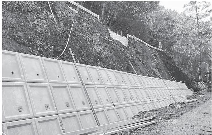
・工事延長L1156m、コンクリートブロック工(大型ブロック積)A11447m、路側防護柵工(ガードレール)L1156m
