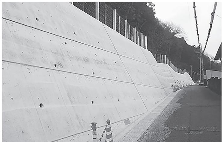
・工事延長L1135m、鉄筋挿入工L1103m、場所打擁壁工L1131m、落石防護工L1131m
