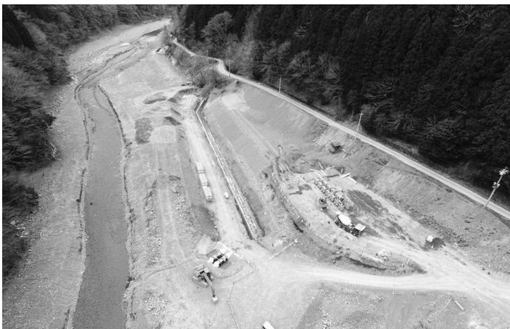
・工事延長L1142m、大型ブロック積A11909m、根固めブロック134個
