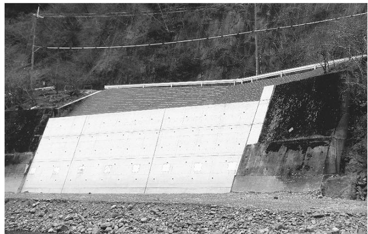
・工事延長（復旧延長）L1130.7m、場所打擁壁工（もたれ式擁壁）V1150.3m（H119.5m、L1122.4m）、グラウンドアンカー工N118本
