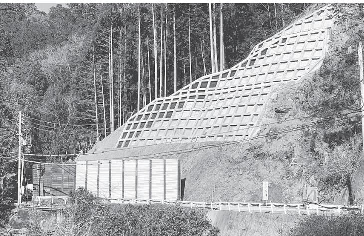
・工事延長L1127.1m、吹付法枠(300×300)15×15(A)1362㎡、鉄筋挿入工(D)19L13.0m×4.5m(N)11
