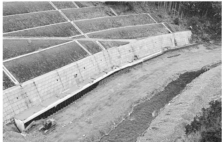
・工事延長L1141.5m（復旧延長L1133.6m）、矢板工ⅢW型（L118.5m）51枚、L119.5m179枚、根固めブロック工（6t新設）64個
