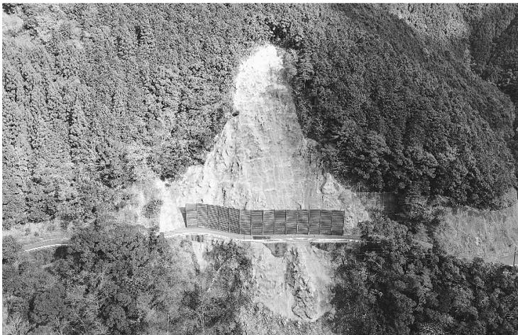
・工事延長L1171m、吹付法枠工L4103m、鉄筋挿入工N1368本、落石防護網工A1765m、アスファルト舗装工A1248m
