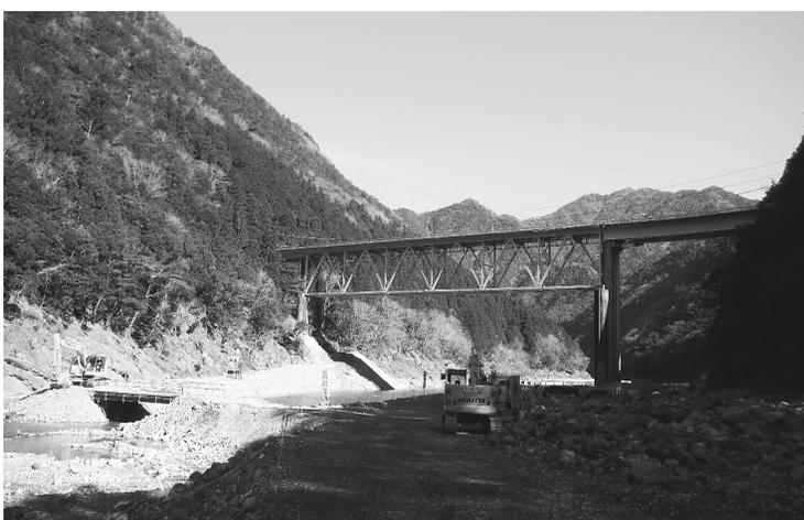
・工事延長L1163m、RC巻き立て工V11282m、ひび割れ充填工L112.3m、ひび割れ注入工L116.7m
