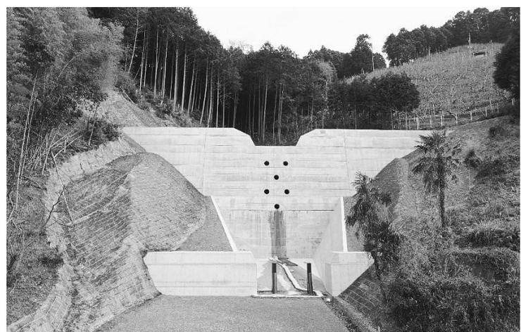
・工事延長L1126.9m、コンクリート堰堤工N11基、垂直壁工N11基、鋼製スリット工N12基、側壁工L116.6m、水叩工L116.6m
