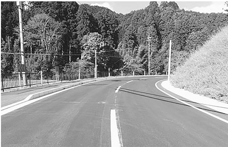
・工事延長L11240m、盛土工V11400m、側溝工(自由勾配側溝)L1116m、縁石工L11239m
