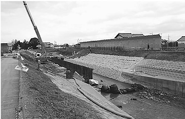
・工事延長L1163m、アンカー式空石積工A11272m、自然石固着金網張護岸工A11500m
