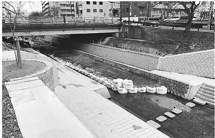
・工事延長L1127m、コンクリートブロック工(フロック積)A11316m、ブロック舗装工(平石張)A11207m
