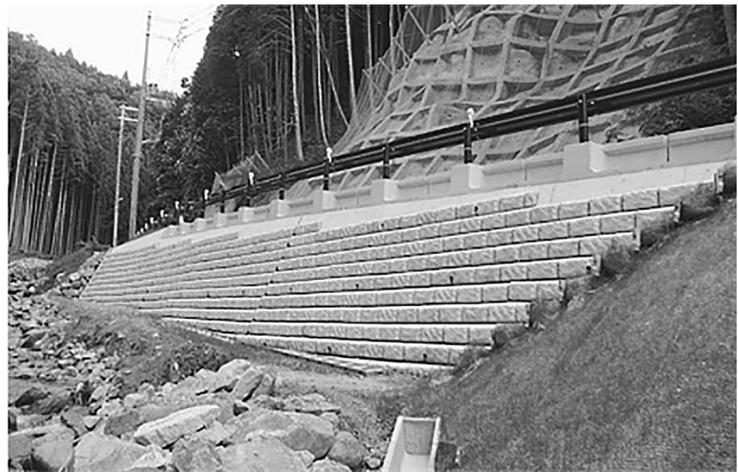
・工事延長L1163m、アンカー式擁壁工L1127m、側溝工L11375m、路側防護柵工L1165m
