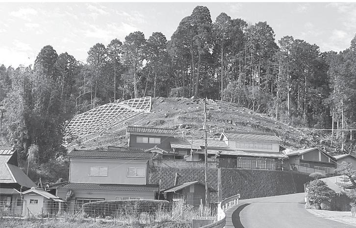
・工事延長L125m、鉄筋挿入工N97
