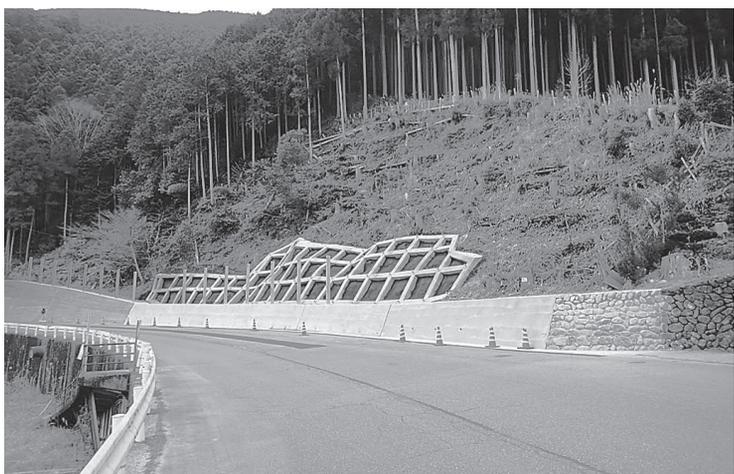
・工事延長L67m、吹付法砕工A1165m<sup>2</sup>、鉄筋挿入工N50本、落石防護柵工L67m
