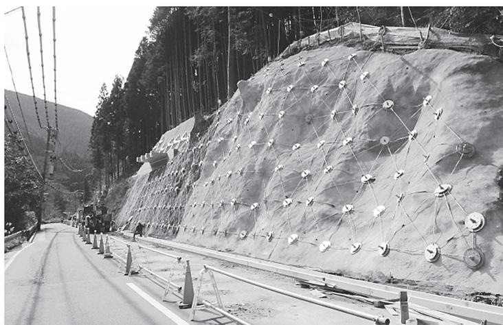
・工事延長L75m、鉄筋挿入工N1175本、モルタル吹付工A208m<sup>2</sup>、植生工A1170m
