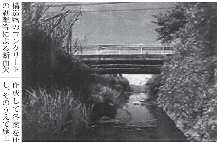
補修設計を行う高510号線1号橋
