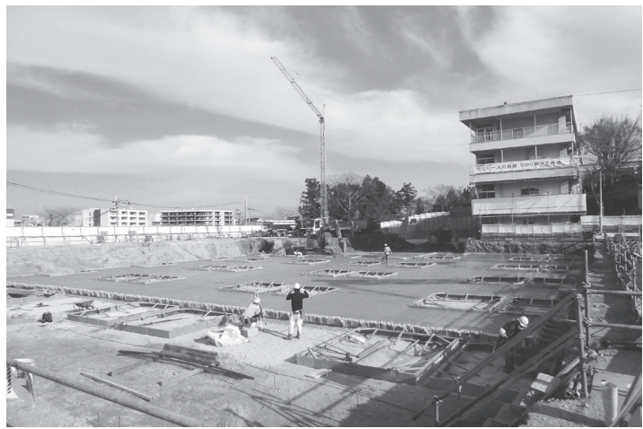
基礎工事が進む現場 (11日撮影)
