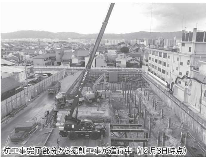
杭工事完了部分から掘削工事が進行中(12月3日時点)
